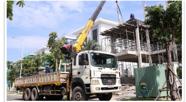
Aqua City giữ vững nhịp thi công hoàn thiện xây dựng và cảnh quan
